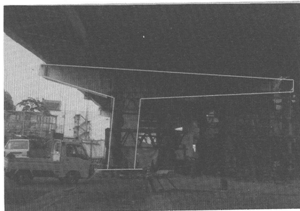
図-2 被害を受けた橋脚躯体およびアンカー部の構造諸元
