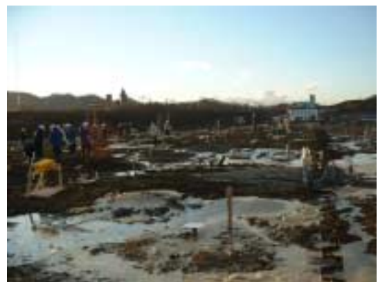
写真-2 岸壁背後地盤の噴砂状況
