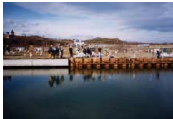
写真-1 耐震岸壁（左側）と非耐震岸壁（右側）
