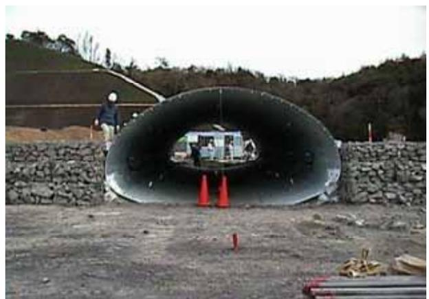
写真1 コルゲートカルバートの施工状況
