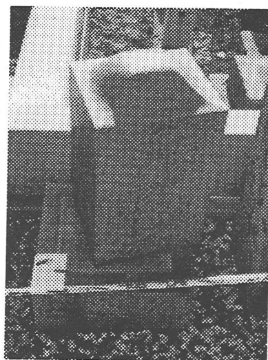
写真-1 地震後の現地調査の際に撮影された墓石の回転の様子
