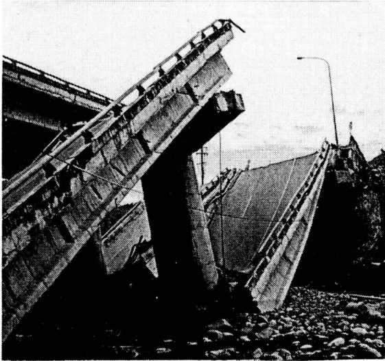
写真-3 東勢方面線 P2 橋脚の橋軸方向への傾斜
