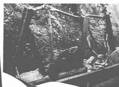
写真-4 落石防止擁壁の防護柵に直撃し、支柱の降伏、擁壁コンクリートの破壊、擁壁の転倒状況
