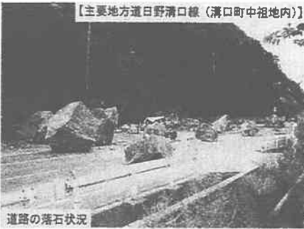
写真－2 落石の氾濫・到達範囲状況 到達距離は斜面直下より最大 30m、大部分は 15m 位までに停止する。（鳥取県写真）
