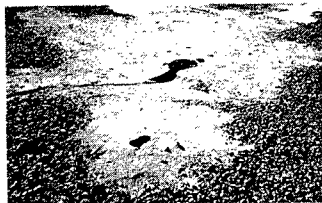
写真-34号埠頭のエプロン上の噴砂
