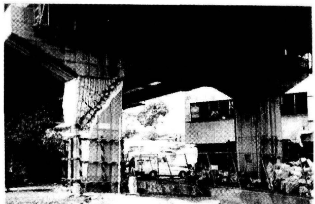
写真-1 RCラーメン橋脚の柱部せん断被災例
