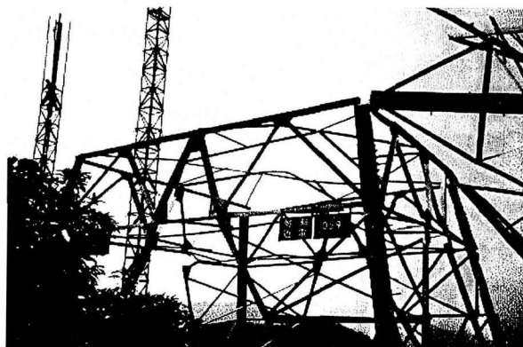
写真-3 部材が途中から折れて倒壊した 161kV 高压送電鉄塔
