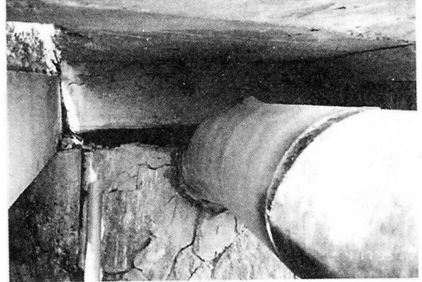
写真-3 左岸側の状況 (神戸市須磨区)
