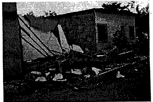
図3 ブロック造家屋の被害
