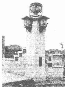
写真－6 船河原橋の親柱
