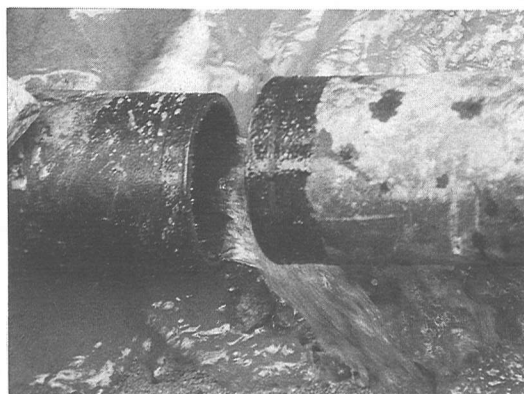
写真-1 ガス管修繕中にガス管内から流出する差し水
