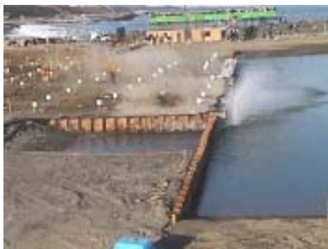
写真 - 1 発破状況(側面より)
