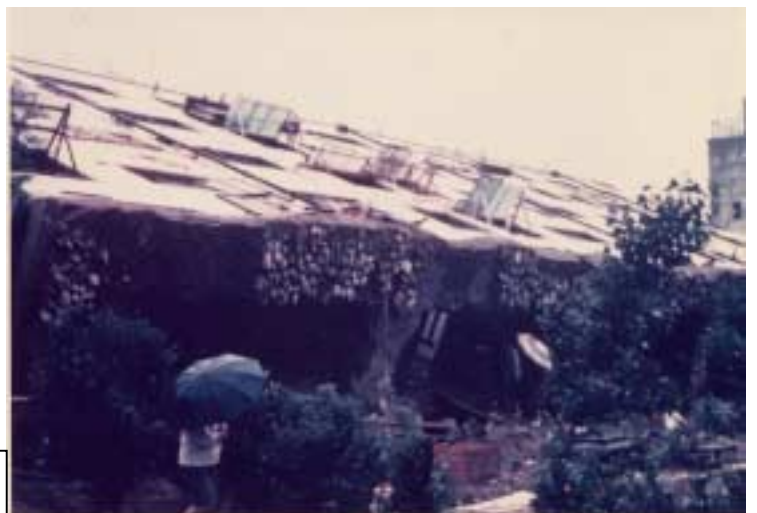
新潟地震、液状化、横倒しアパート
