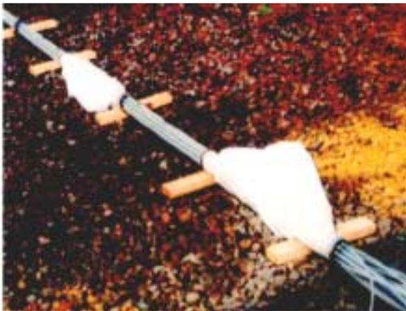
写真-3 袋パッカを装着した結束細管
