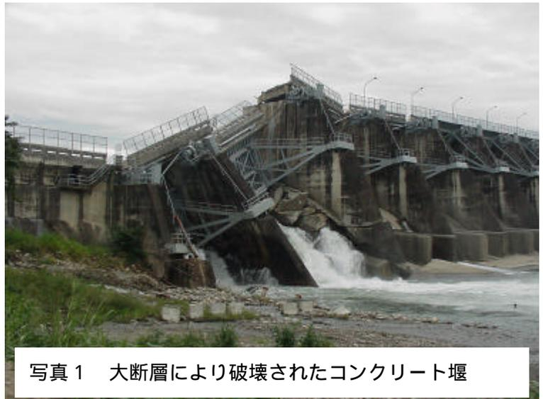
写真1 大断層により破壊されたコンクリート堰
