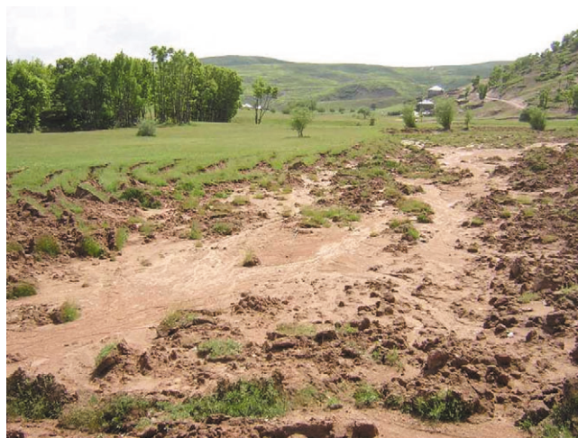
写真-3 Hanocayiriの液状化に伴う側方流動
