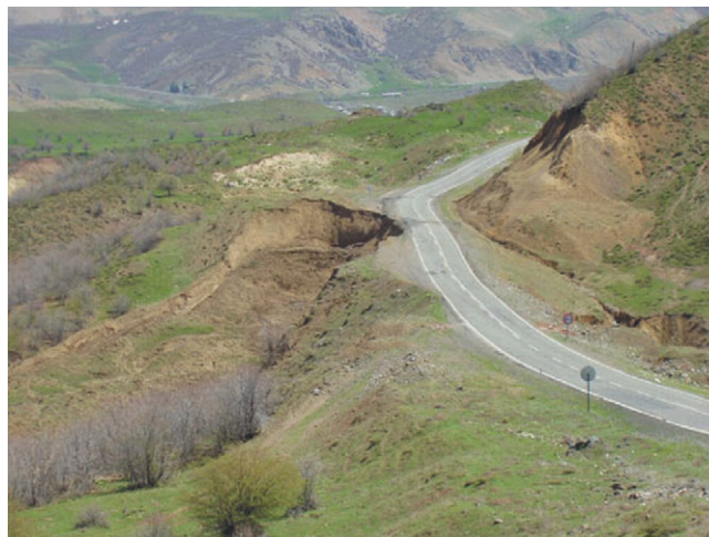
写真-1 ハイウェイにおける斜面崩壊
