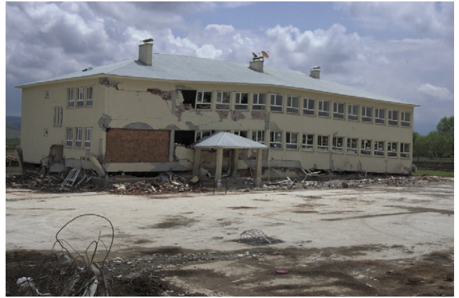
写真-5 Eltiksyu小学校の校舎の倒壊
