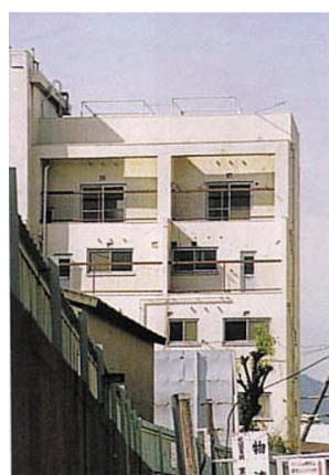
写真-4 修復されたマンション
