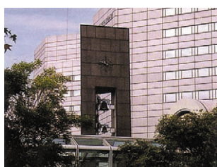
写真-5 地震で傾いた時計塔
