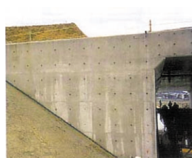
写真-1 施工前のカルバート
