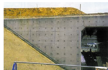
写真-2 施工後のカルバート
