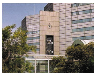
写真-6 修復された時計塔
