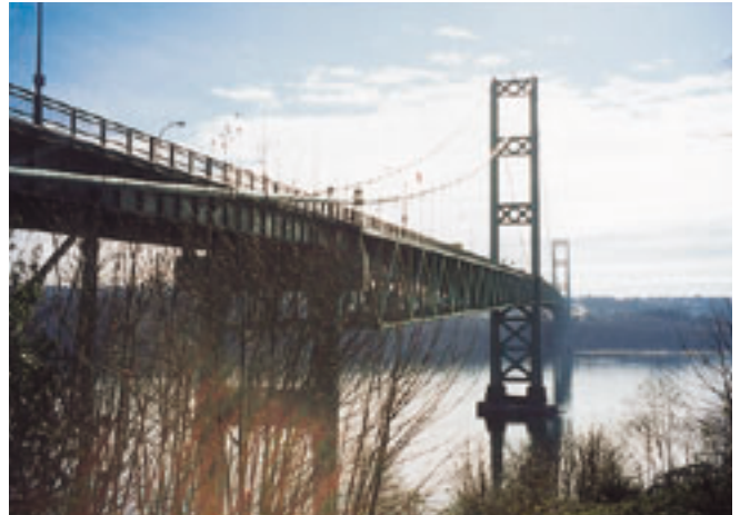
写真-6 被害を受けなかったタコマナローズ橋
