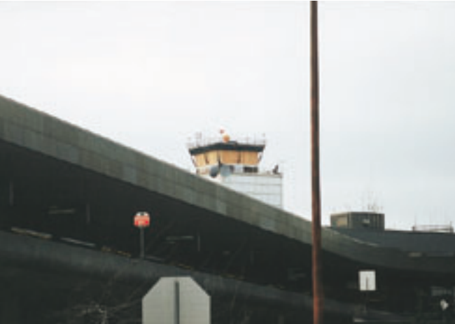
写真-1 シアトル・タコマ国際空港の管制塔の被害
