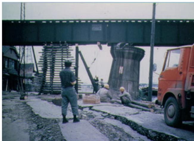
写真-1 川岸の地盤の流動を物語る被害 (越後線信濃川橋梁, 渡辺隆博士提供)
