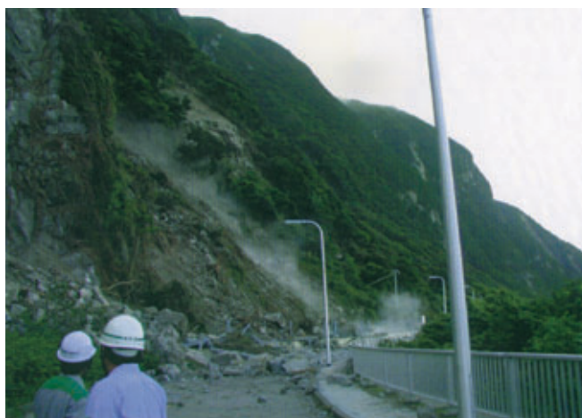
写真-2 新島・檜山での道路被害（7月19日に発生した崩落の瞬間）
