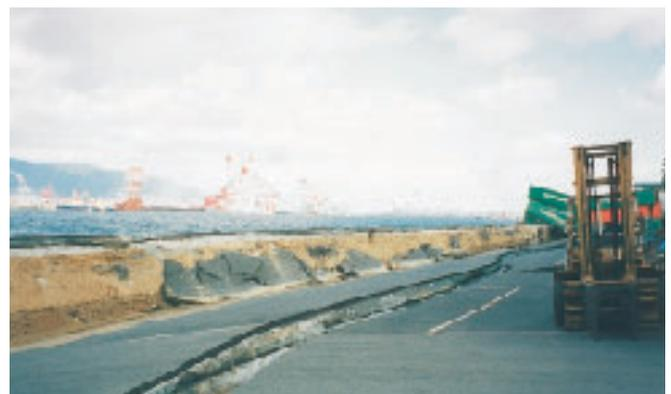
写真-2 陥没と舗装の亀裂
