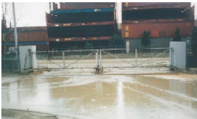
写真-3 液状化による噴砂
