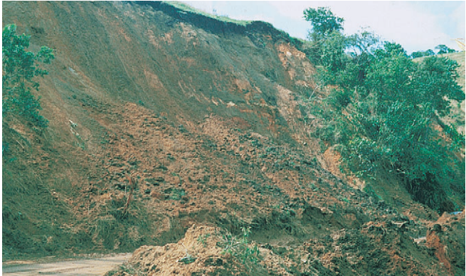
写真-2 斜面崩壊による崩土が道路を覆った現場（提供：E. Rodríguez Grandos）
