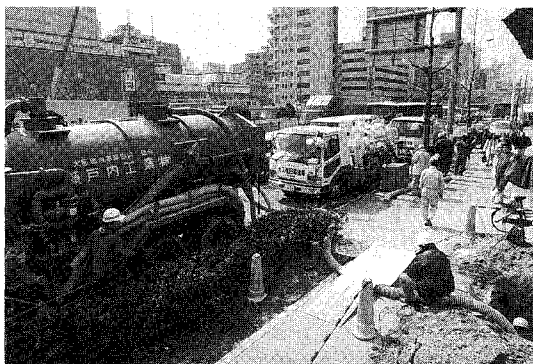
写真-3 バキュームカーによる土砂の排除作業
