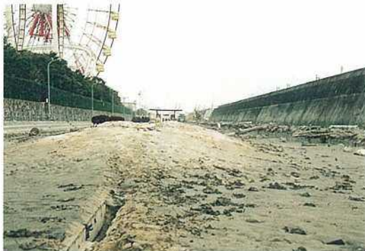
写真-2 ポートアイランドの旧護岸背後の噴砂の状況
