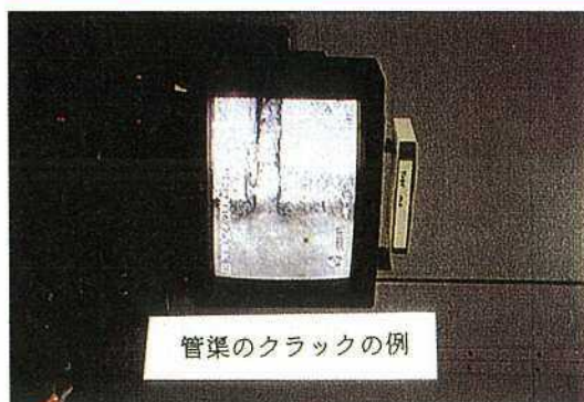
写真-6 テレビカメラによる下水管渠の調査
