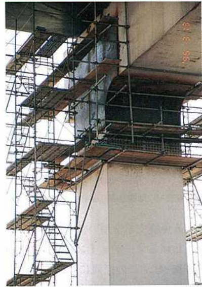
写真-3 脆性破壊による亀裂の復旧
