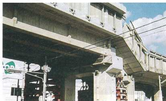
写真—16 PC桁を支える健全なラーメン橋脚
