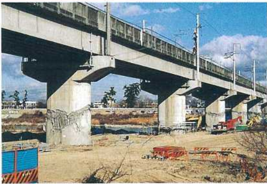
写真-11 武庫川橋梁の小判型橋脚
