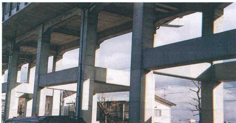
写真-1 中間ばりを有するラーメン高架橋
