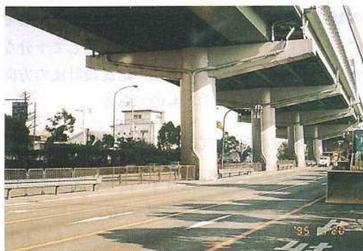
写真-6 単柱式円形橋脚
