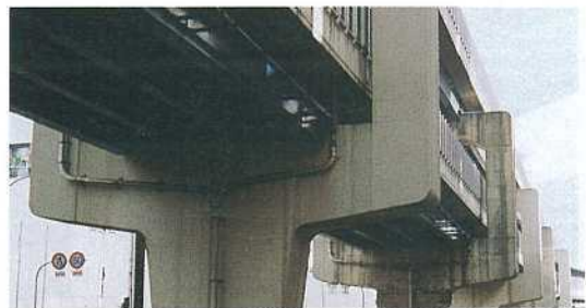
写真-13 単柱(壁)式二層ラーメン橋脚
