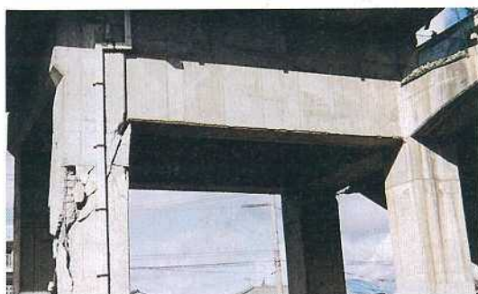
写真-4 ラーメン橋台（高さの高いはり）
