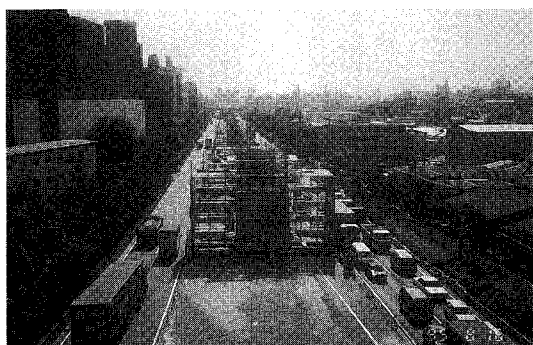
写真-1 ビルツ区間復旧状況
