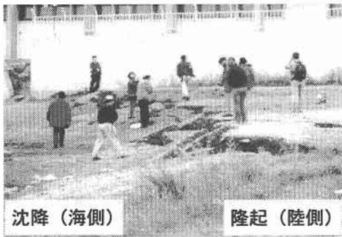
写真-1 ギョルジュク市内での正断層型の地盤変位
