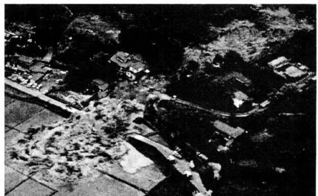
写真2 築館町のすべり崩壊（国際航業（株）提供）
