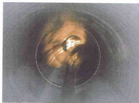
図 8.5-2 FRPM 管内挿状況
