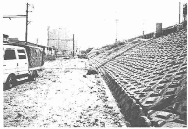
・シートパイルによるバラスト止めの設置 写真 4. 2. 3-2 海側のり面の仮復旧時
