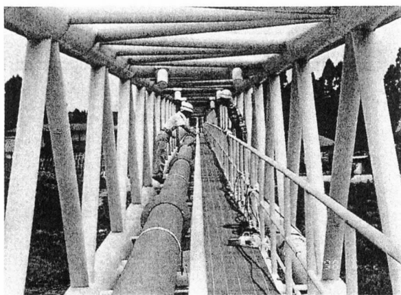
写真-5.2 D水管橋の人力加振状況
