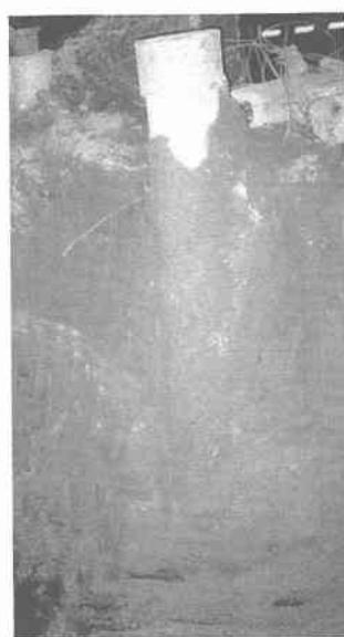
写真-7.2.9 杭打設の痕跡
