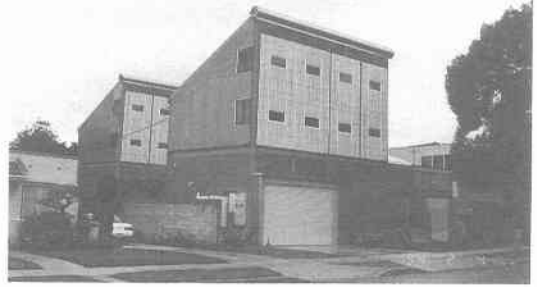
写真 8.2.49 鉄骨造3階建て免震構造住宅
