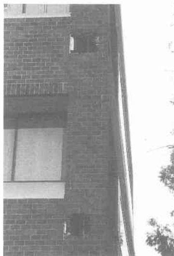
写真 8.2.38 外壁の柱一はり接合部補修検査状況 (写真 8.2.37 と同じ建物)
