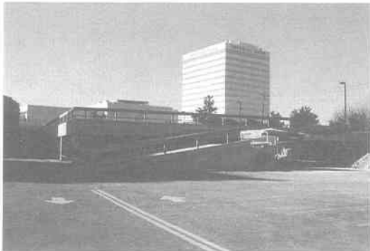
写真 8.2.8 プレキャストコンクリート造 1 層駐車場 (Trans World Bank)
