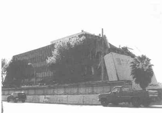
写真 8.2.25 鉄筋コンクリート造 5 階建て診療施設の被害 (Keiser Permanente)
