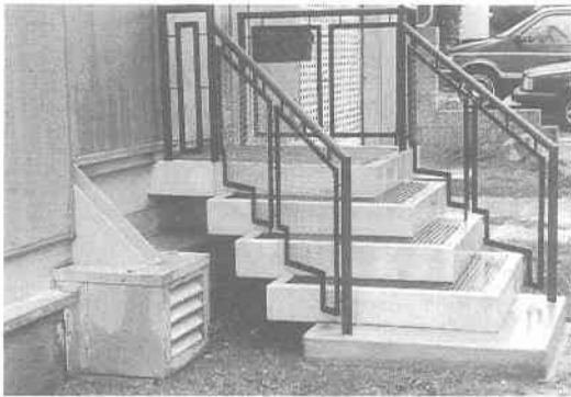
写真 8.2.50 免震構造住宅玄関部 (写真8.2.49と同じ建物)
