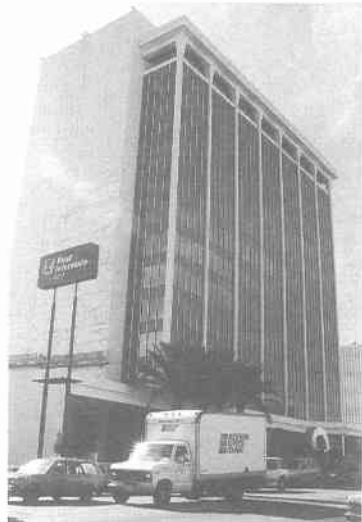
写真 8.2.36 13 層鉄筋コンクリート造銀行 (First Interstate Bank) の亀裂状況
