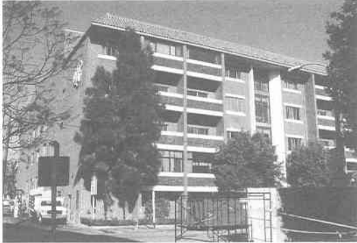
写真 8.2.45 鉄筋コンクリート補強された煉瓦造建物 (Saint John's Medical Center)
