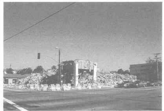
写真 8.2.51 撤去された鉄筋コンクリート造6階建てビル跡
