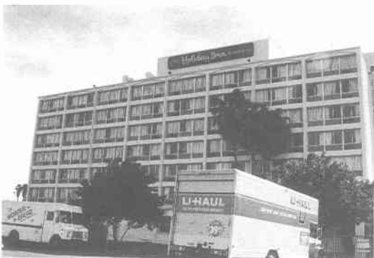
写真 8.2.27 鉄筋コンクリート造 7 階建てホテル (Holiday Inn)
