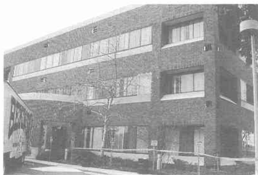
写真 8.2.37 3階建ての鉄骨造サンタ・クラリタ市役所
