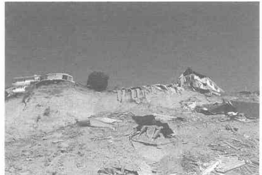
写真 8.2.24 サンタ・モニカの崖崩れ (Pacific Palisades)
