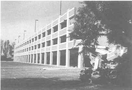
写真 8.2.1 3層プレキャストコンクリート構造駐車場の側面 (California State University Northridge / Parking)
