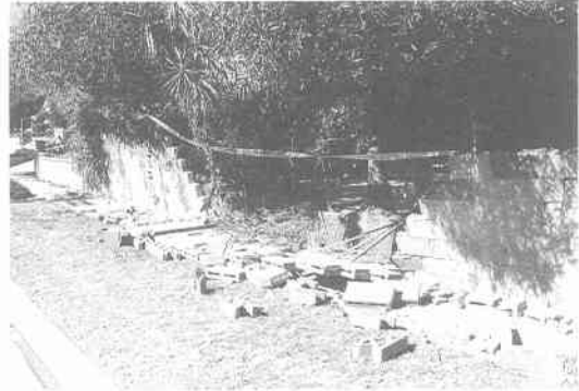
写真 8.2.47 無筋コンクリートブロック造塀の倒壊 写真 8.2.48 鉄筋のあるコンクリートブロック造塀の倒壊
