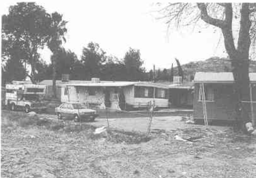
写真 8.2.52 モービル・ホームの被害
