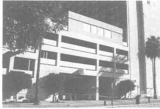
写真 8.2.6 鉄筋コンクリート造 3 層駐車場 (Raddison / Parking)
