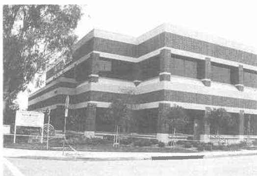
写真 8.2.39 鉄骨造2階建ての1層破壊 (AAA / Auto Club)
