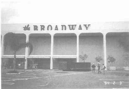
写真 8.2.12 3層鉄筋コンクリート造デパート (The Broadway; Topanga Fashion Mall)
