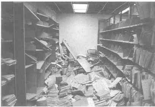
写真 8.2.43 病院下階での資料棚からの散乱状況 (写真 8.2.41 と同じ建物)
