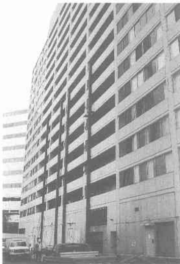
写真 8.2.31 鉄筋コンクリート造16階建て共同住宅 (Champagne Towers)
