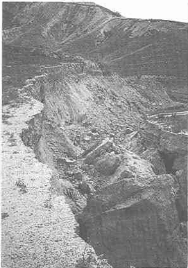
写真 4.4.16 堆積場の崩壊 (タポ峡谷)
