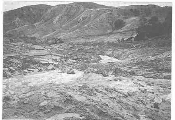
写真 4.4.18 堤体の崩壊により流出した堆積物 (タポ峡谷)
