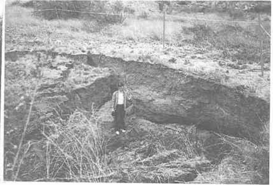
写真 4.3.5 液状化による大きな陥没 サンフェルナンド下ダム
