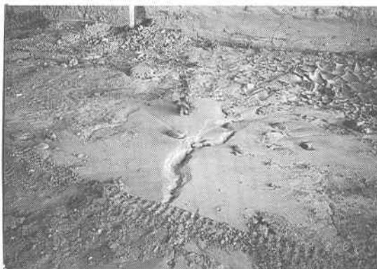
写真 4.4.7 サンタクララ川を横切る橋近くの液状化
