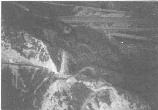
写真 4.4.19 15/SR14 インターチェンジ付近の斜面崩壊 (EERC 提供)
