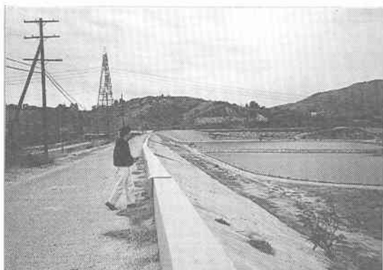
写真 4.3.9 サンフェルナンド上ダムの上流側斜面
