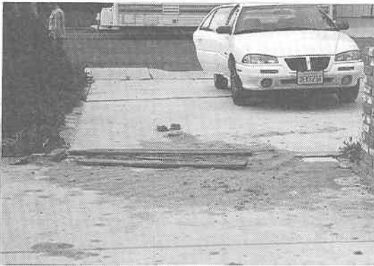
写真 4.4.13 住宅の庭先で見られた噴砂 (シミバレー)
