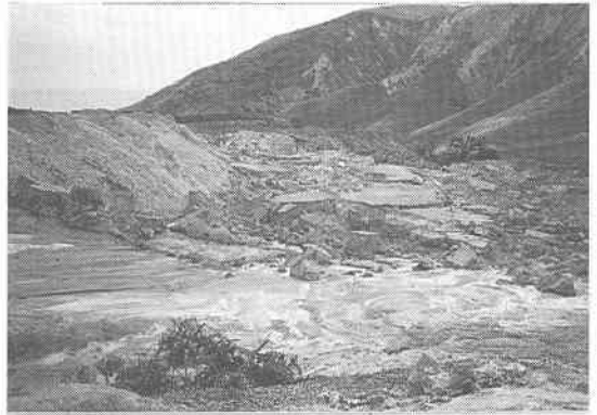
写真 4.4.17 堆積場の崩壊 (タポ峡谷)
