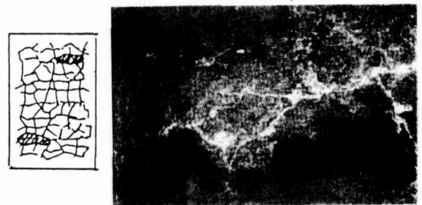
写真-3.41 遊離石灰の漏出 31)
