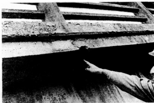
写真-3.47 床版横締め定着部の損傷事例 20)
