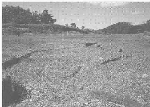
写真 9.6.2 耕作地に生じた亀裂（知内地区）
