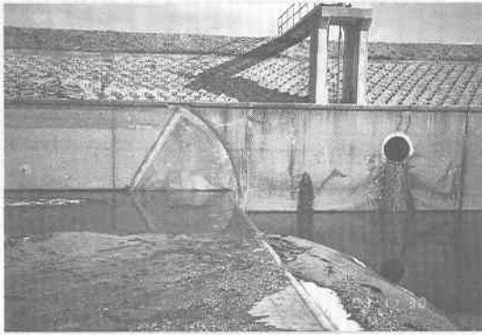
写真 9.5.5 転倒ゲートの戸当りプレート [丹羽頭首工]
