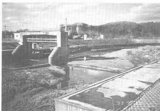
写真 9.5.3 丹羽頭首工全景
