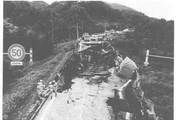
写真7.1.2 国道5号長万部町知来の盛土崩壊
