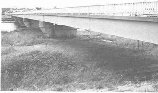
写真 7.2.14 柳崎橋の全景
