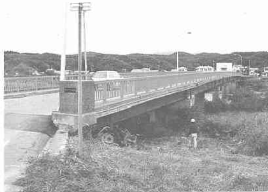
写真 7.2.9 基栄橋の全景
