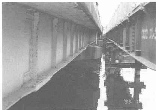
写真 7.2.6 新有川橋の全景
