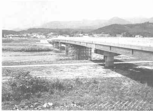
写真7.2.24 新知内橋の全景
