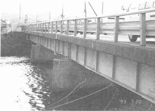
写真 7.2.1 上磯新橋の全景
