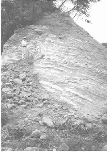
写真 7.3.2 道道 1170 号線沿いの崩壊 (その 2)
