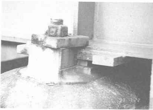
写真 7.2.16 柳崎橋橋台の支承部（桁と下部構造間の相対変位）
