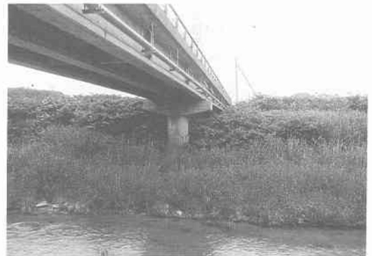
写真 7.2.22 元瓜谷橋の全景
