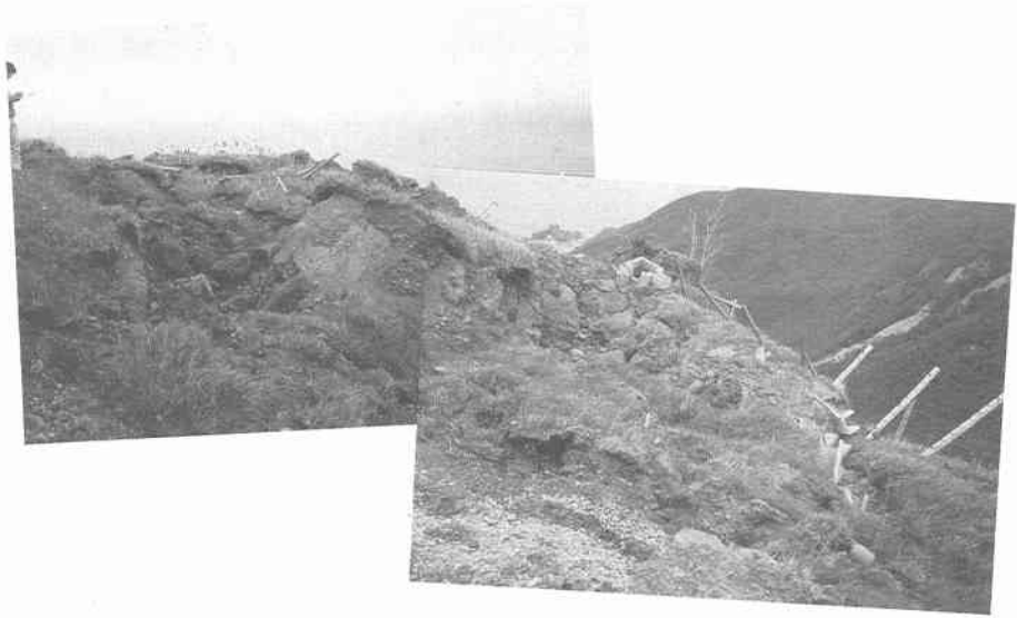
写真 7.3.5 大規模崩壊地
