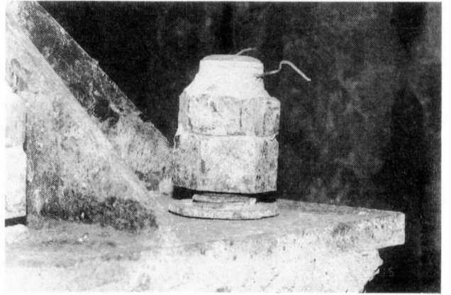
写真1-8 鋼製橋脚のアンカーボルトの抜けだし
