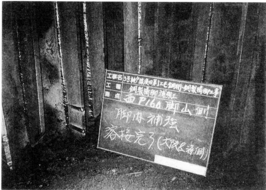
写真 1 - 1 6 損傷部の部分的取り替えと縦補剛材の追加
