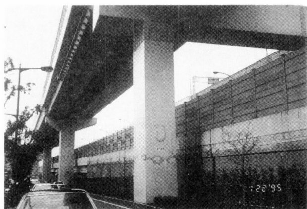
写真1-1 鋼製ラーメン橋脚基部の局部座屈
