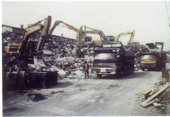
写真-2 建築系災害廃棄物の撤去現場
