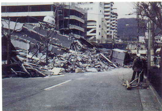
写真-1 倒壊した駐車場ビルにより通行不能な街路（JR芦屋駅前）
