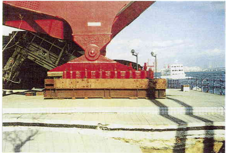
写真－8 神戸大橋の神戸側の支承
