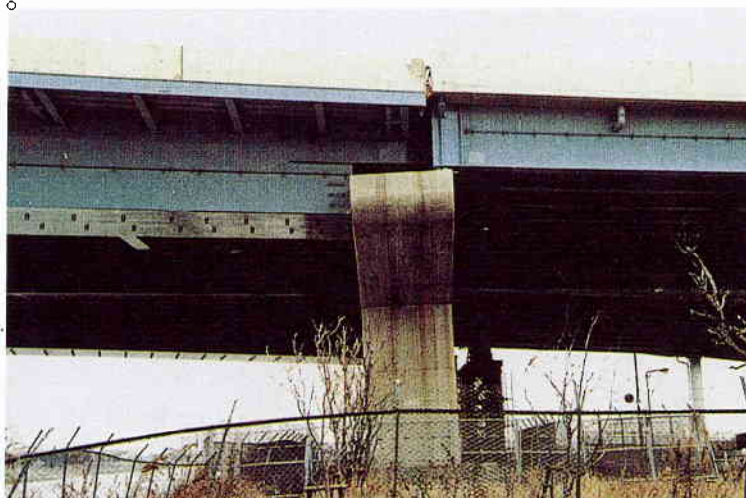
写真－5 新夙川橋の西宮浜側の橋脚
