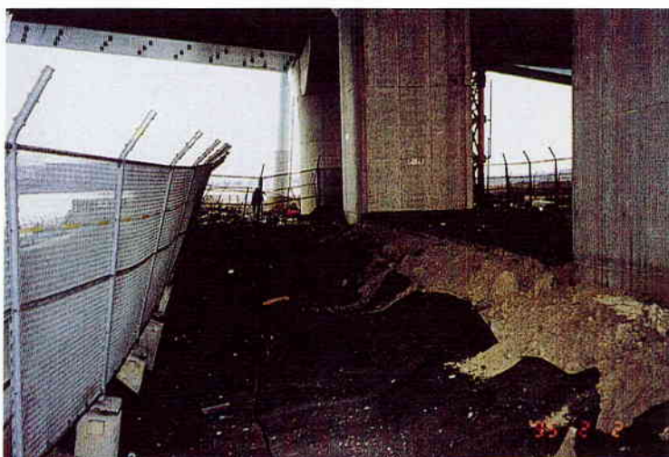
写真－7 護岸と橋脚の間の地盤状況
