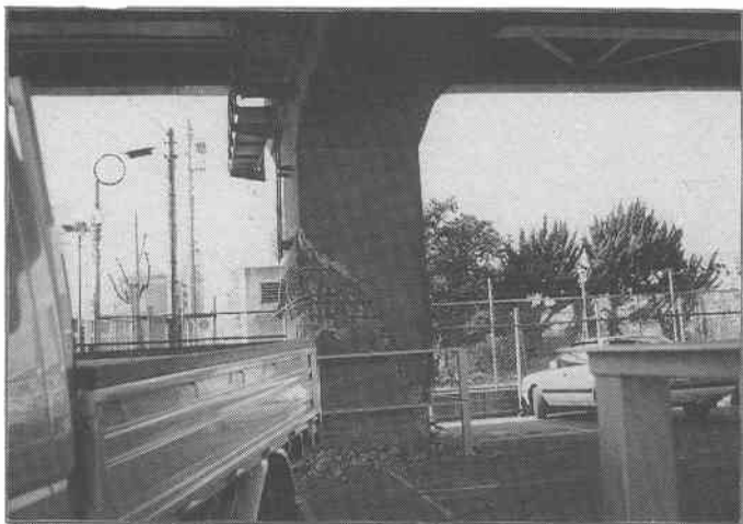
ラーメン橋脚のせん断破壊
