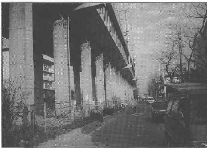
写真4 山陽新幹線の被害
