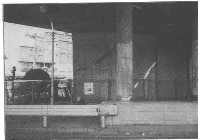
ロッカー橋脚の傾斜
