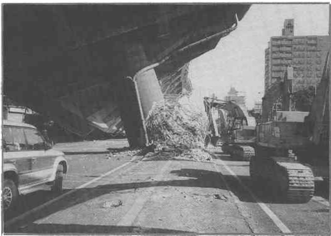
圧接部付近のせん断破壊と思われる例
