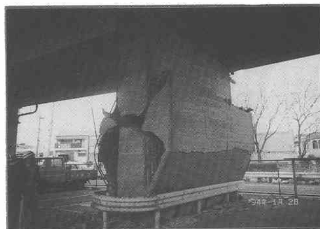
壁式橋脚のせん断破壊
