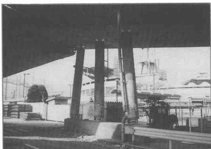
ロッカー橋脚の傾斜
