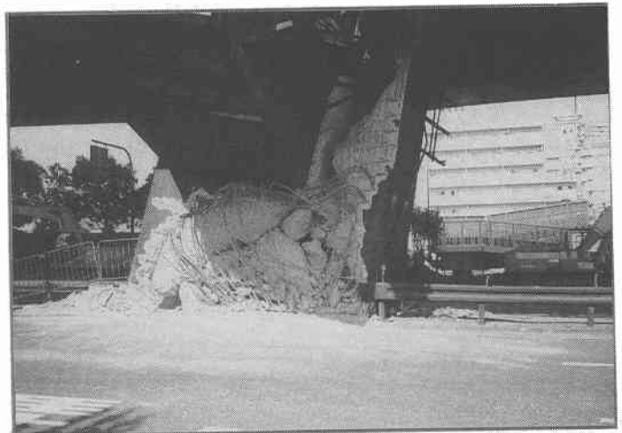
短柱のせん断破壊？
