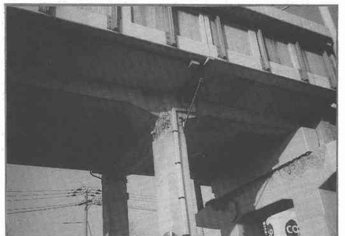
写真4 山陽新幹線の被害
