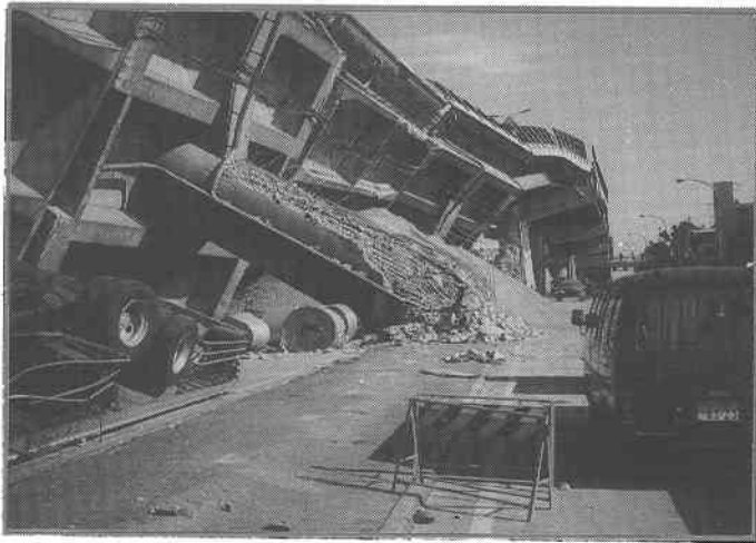
段落とし部のせん断破壊と思われる例
