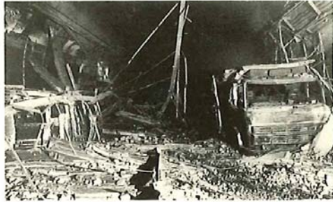
東名日本坂トンネル内 で車両火災事故発生 (1979年7月11日)
