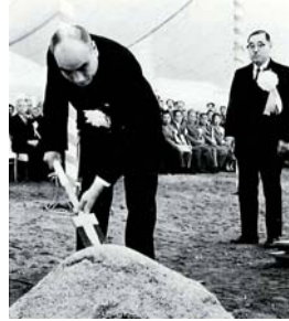
名神高速道路起工式で鍬入れ する岸道三初代日本道路公団 総裁(1958年10月19日)
