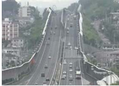
名神6車線改築区間 (高槻バスストップ付近)
