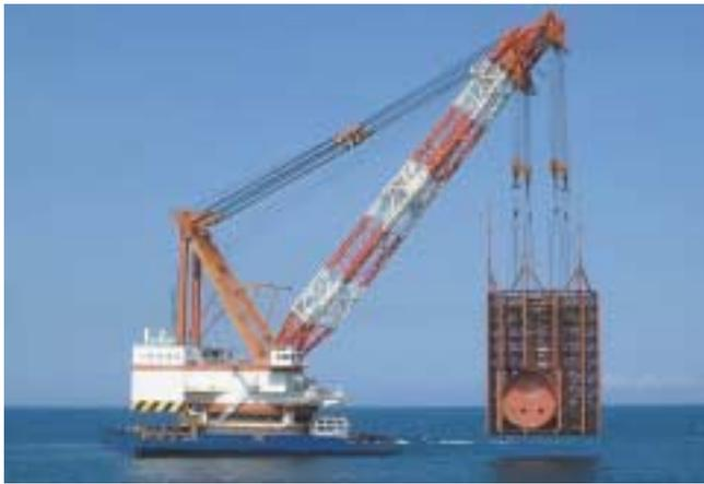
写真-2 1 600 t吊起重機船によるJ管据付け作業
