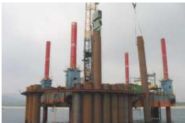
写真-1 パイプロハンマーによる鋼管矢板打設状況
