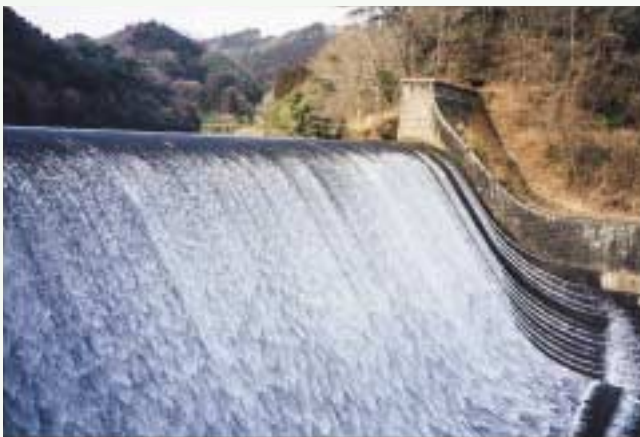
写真-4 重要文化財 白水溜池堰堤水利施設（主堰堤）
