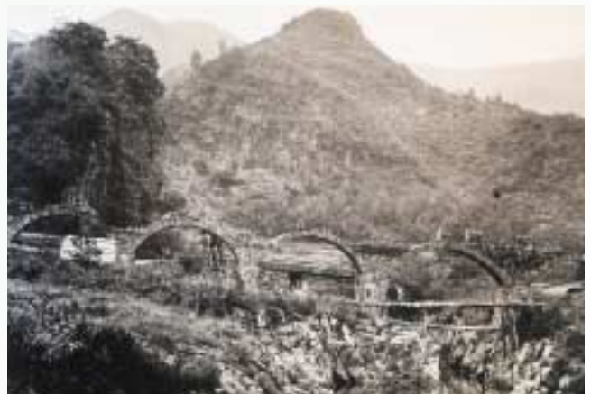
写真-5 第一拱石橋の架設工事状況 （写真提供：緒方町歴史民俗資料館）
