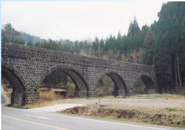
写真-1 明正井路第一幹線1号橋（第一拱石橋）
