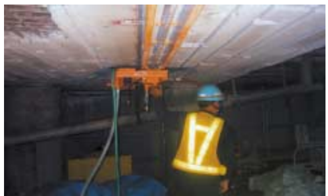
写真-4 溝切削の機械化
