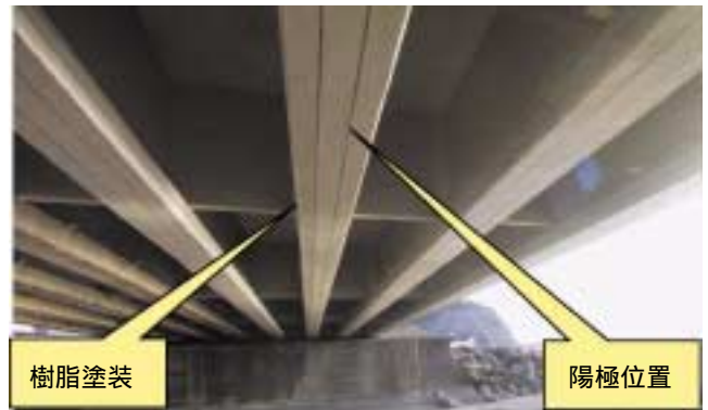
写真-1 チタングリッド陽極の設置
