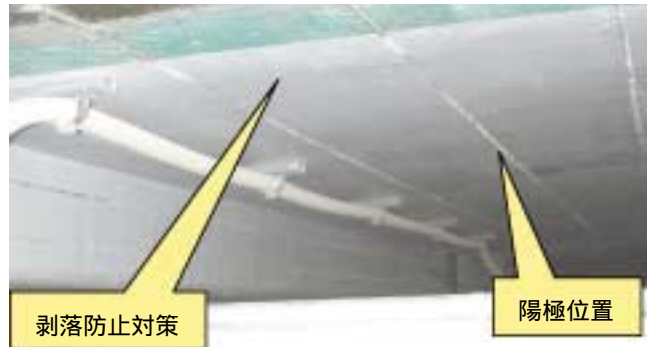
写真-2 剥落防止工法との併用
