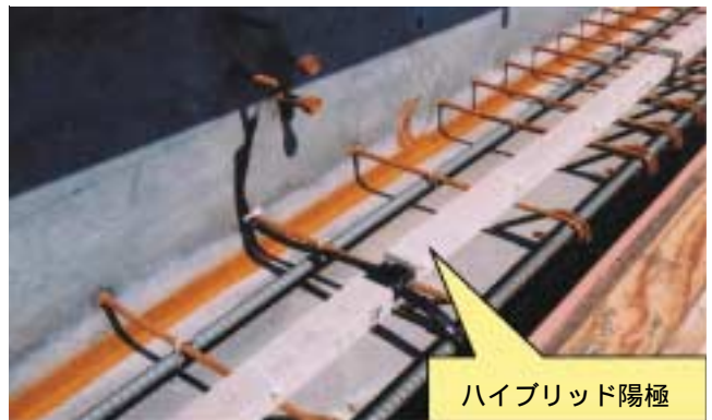
写真-3 ハイブリッド陽極の設置
