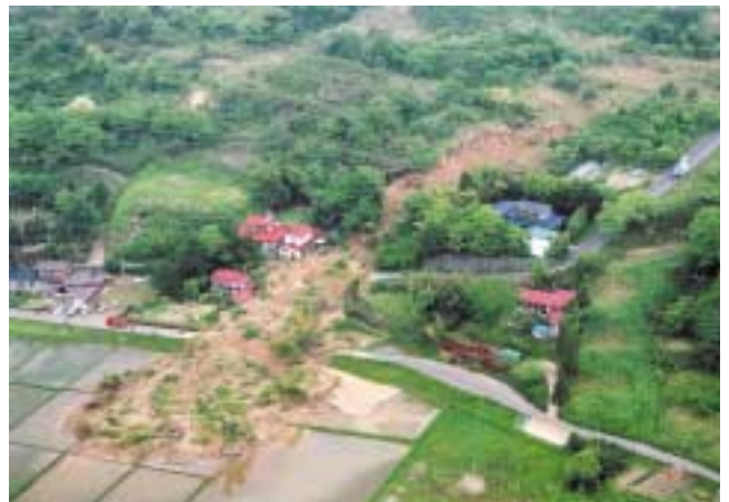
写真-3 宮城県築館町斜面流動破壊現場の空撮 (5/27 9時: パワードパラグライダー [PPG] 空撮 ㈲ミヤギエンジニアリング)
