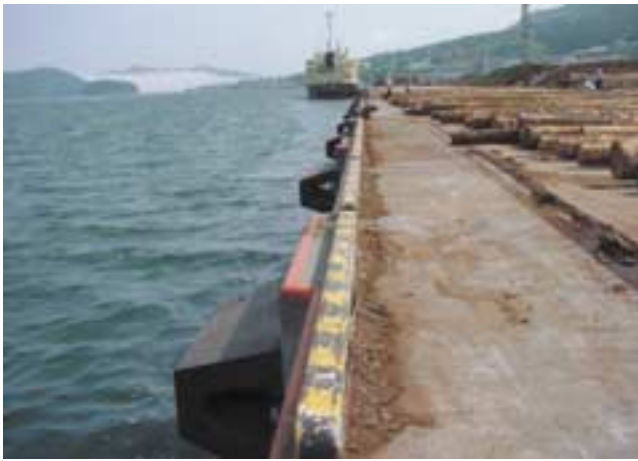
写真-4 岸壁法線および木材の野積み状況
