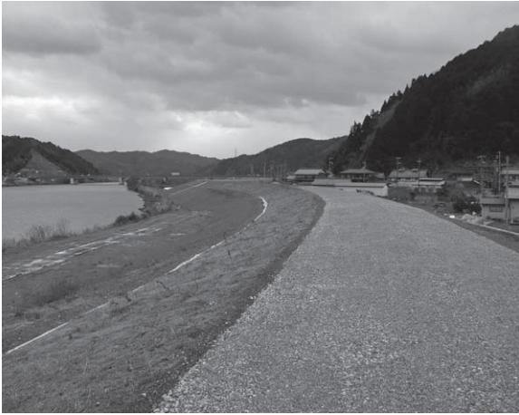
写真1 輪中堤が由良川に沿って築かれている
